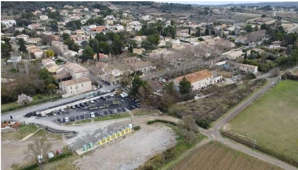
Vue de la partie aménagée du parking et de la parcelle stratégique dégradée
