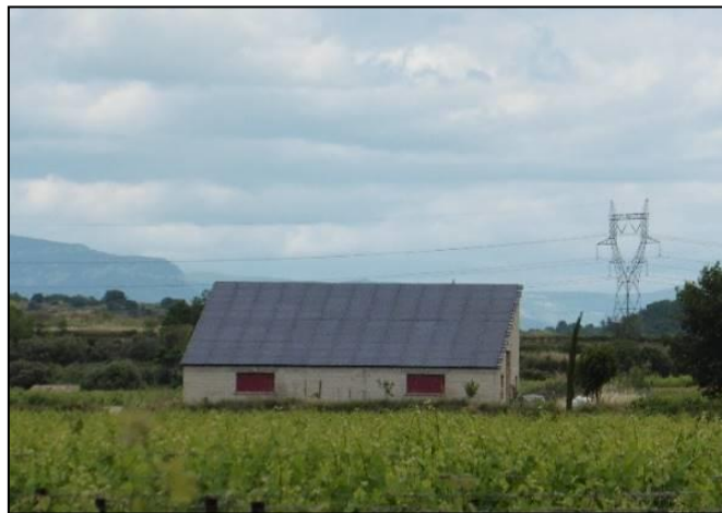
Panneaux photovoltaïques sur toitures de bâtiments d'exploitation (commune de Campagnan)
